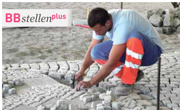
Eine knifflige Sache, so eine Gehwegaufweitung. Beim Landesleistungswettbewerb stellten die sechs besten Straßenbauer ihr Können unter Beweis. Bild: Bauwirtschaft Baden-Württemberg
