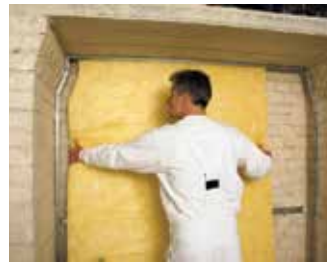
Bei vielen Gebäuden hilft eine Innendämmung beim Energie-sparen. (pb) Foto: Fachverband Mineralwolleindustrie e.V.
