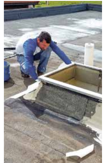
Der Flüssigkunststoff legt sich wie eine zweite Haut um alle Details des Flachdachs und dichtet so langfristig und sicher ab.
