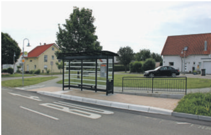
Bushaltestelle Hailfinger Straße (Backenschlag)
