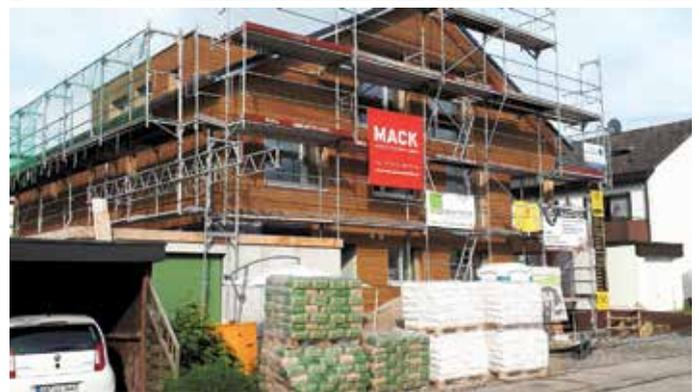
Komplett aus Holz sind die mehrschichtigen, vorgefertigten Fassadenelemente. Lediglich die Innenverkleidung erfolgt im Zuge des Ausbaus.
