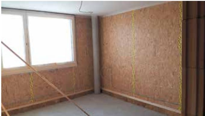
Die Außenwand von innen gesehen: Die raumseitige Verkleidung erfolgt erst im Zuge des Innenausbaus. Vorteil ist die große Flexibilität beim Platzieren von Leitungen und Anschlüssen. Foto: Helmut Link
