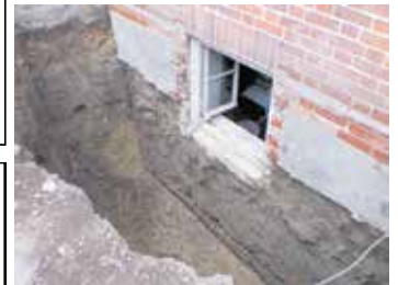
Oft problematisch ist die Abdichtung der Kellerwände. Ist sie überhaupt vorhanden? Und wenn ja, müssen Abdichtung und Drainage erneuert werden?
