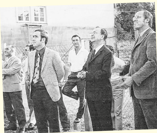
Der frühere Bürgermeister Walter Bauer (Mitte) mit seinem Nachfolger Gerhard Kilian (2.v.l.), dem damaligen Gemeinderat und stellv. BM Walter Rapp (ganz links) und Architekt Klumpp (ganz rechts) beim Richtfest im September 1971.
