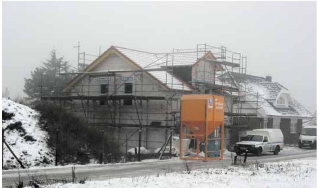
Foto: Verband Privater Bauherren Regionalbüro Wiesbaden
