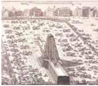
Der Vatikanische Obelisk, der im Jahr 1586 auf dem Platz vor dem Petersdom in Rom aufgestellt wurde, drohte zu misslingen. 220 Meter lang sind die Seile, um den 25 Meter hohen und 300 Tonnen schweren Koloss aufrecht zu setzen. 40 Flaschenzüge und Winden sind im Einsatz. 900 Männer am Werk. Um die Befehle der Bauleute jederzeit verstehen zu
