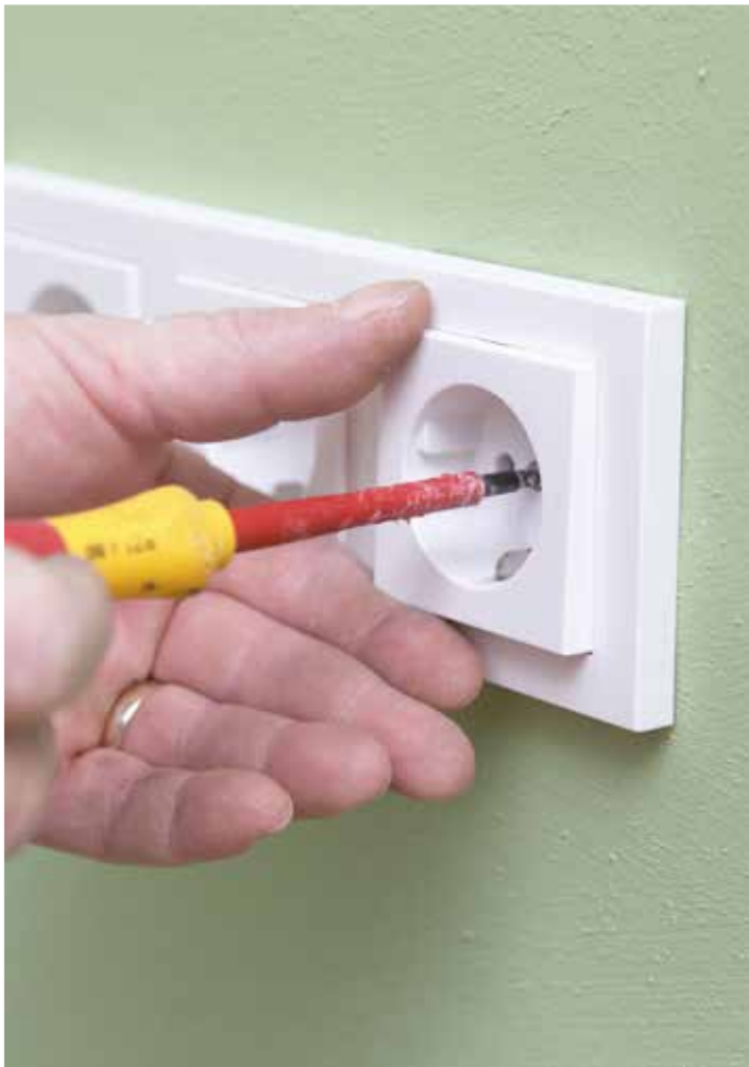
Von Laien durchgeführte Arbeiten an der Elektroinstallation gehören zu den großen Gefahrenquellen im Haushalt. Foto: djd/Elektro+/Jochen Kratschmer
