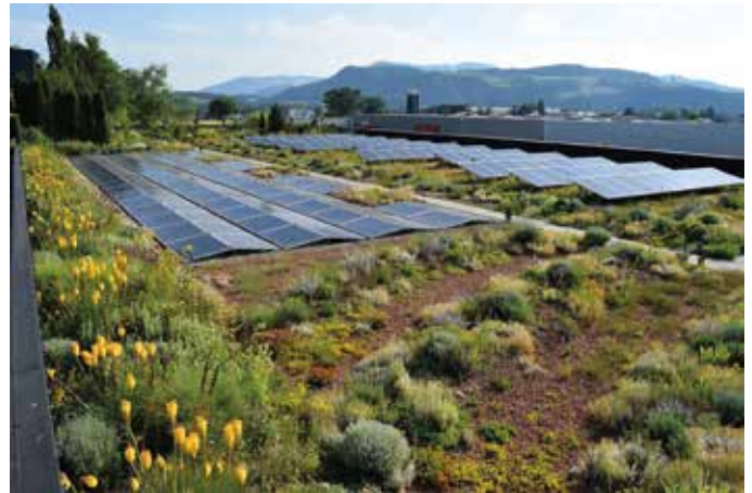
Photovoltaik und Gründächer — perfekte Synergie
